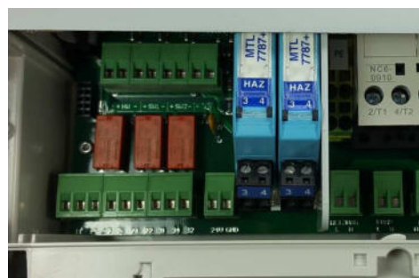
Abb. 2 Stück Zenerbarrieren in 2-Pumpen - mit Trennplatte -
